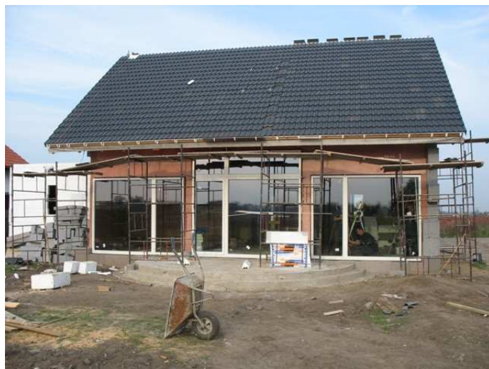
Proiectul locuinței pasive realizat de binecunoscutul birou de proiectare M & L Lipińscy. Pentru etanșarea sistemelor de ferestre a fost utilizat Soudal Window System
